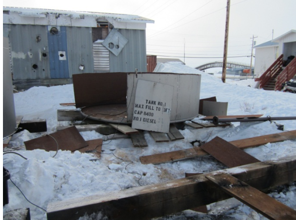
Cutting of fuel tanks on AVEC tank farm site.
