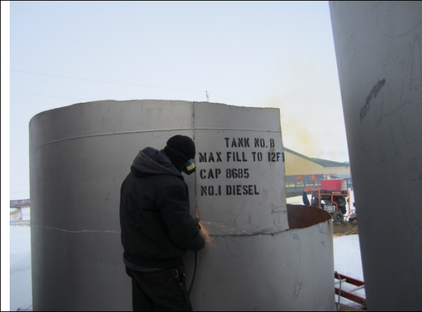
Cutting of fuel tanks at the AVEC tank farm site.
