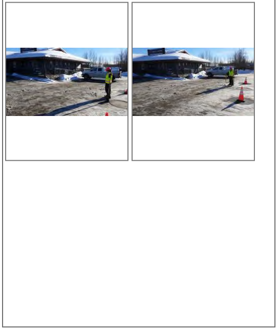
Purge water disposal: Pour on ground
